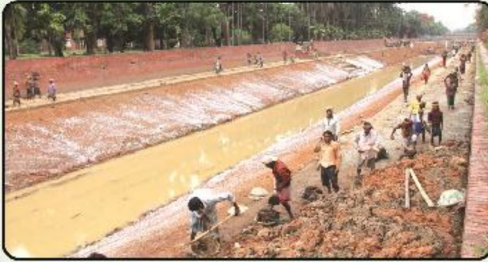
বিএডিসি'র মাধ্যমে গণভবনের লোক পুনঃখনন কার্যক্রম
